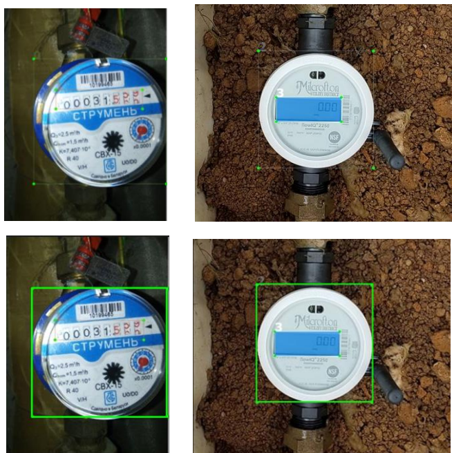
Figura 4. Ejemplos de hidrómetros con carátulas analógicas y digitales y vistas de marcos resaltados.
