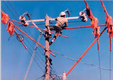
Figura 1. Trabajos en líneas energizadas.
